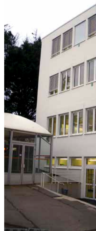
L'extension du bâtiment B apporte un plus, notamment aux élèves en situation de handicap.
